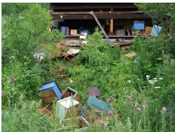
Obr. 10 Včelín poškodený medveďom hnedým
